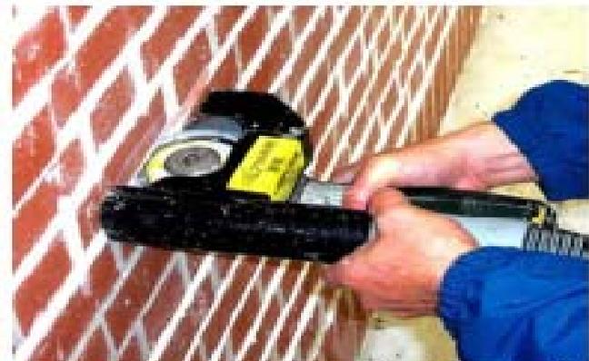
attrezzature munite di dispositivo e con opzioni di utilizzo per taglio in verticale, orizzontale e in presenza di angoli del manufatto.
